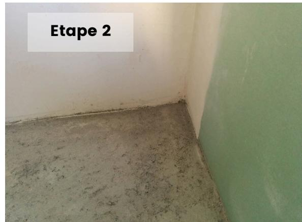
Avant la pose des bandes d'étanchéité d'angle, s'assurer que vos angles soient parfaitement réalisés et sains.
