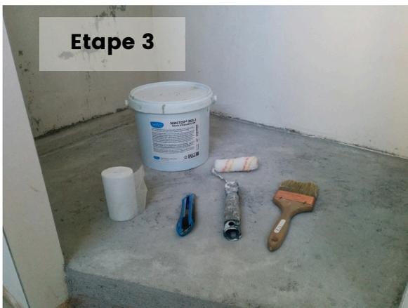
Pour ce faire, munissez vous d'une résine spéciale SEL ( système étanchéité liquide) et d'un rouleau de calicot tarlatane, un pinceau de taille moyenne et éventuellement d'un petit rouleau et cutter.
